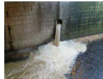
雨天時に汚水混じりの下水が放流され、河川等の水質汚濁や悪臭が発生
