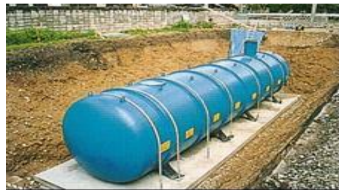
【耐震性貯水槽】
