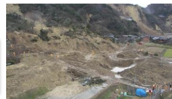
珠州市仁江町の掘削状況
