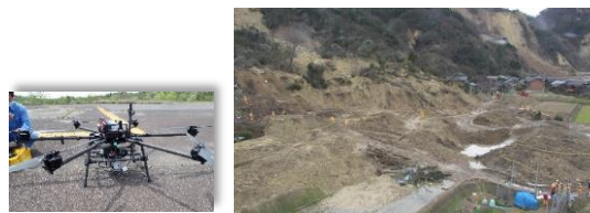
珠州市仁江町の掘削状況
