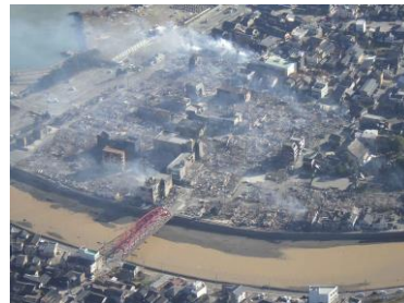
【令和6年能登半島地震で発生した大規模市街地火災】
