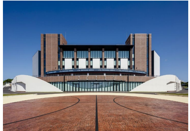
沖縄アリーナ (写真提供：沖縄県沖縄市)
