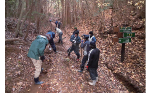
世界遺産 高野参詣道「町石道」の保全活動の様子。多くの観光客が歩くこの道を保全するため月1回の見回りを実施し、倒木処理等の維持管理を行っている。
