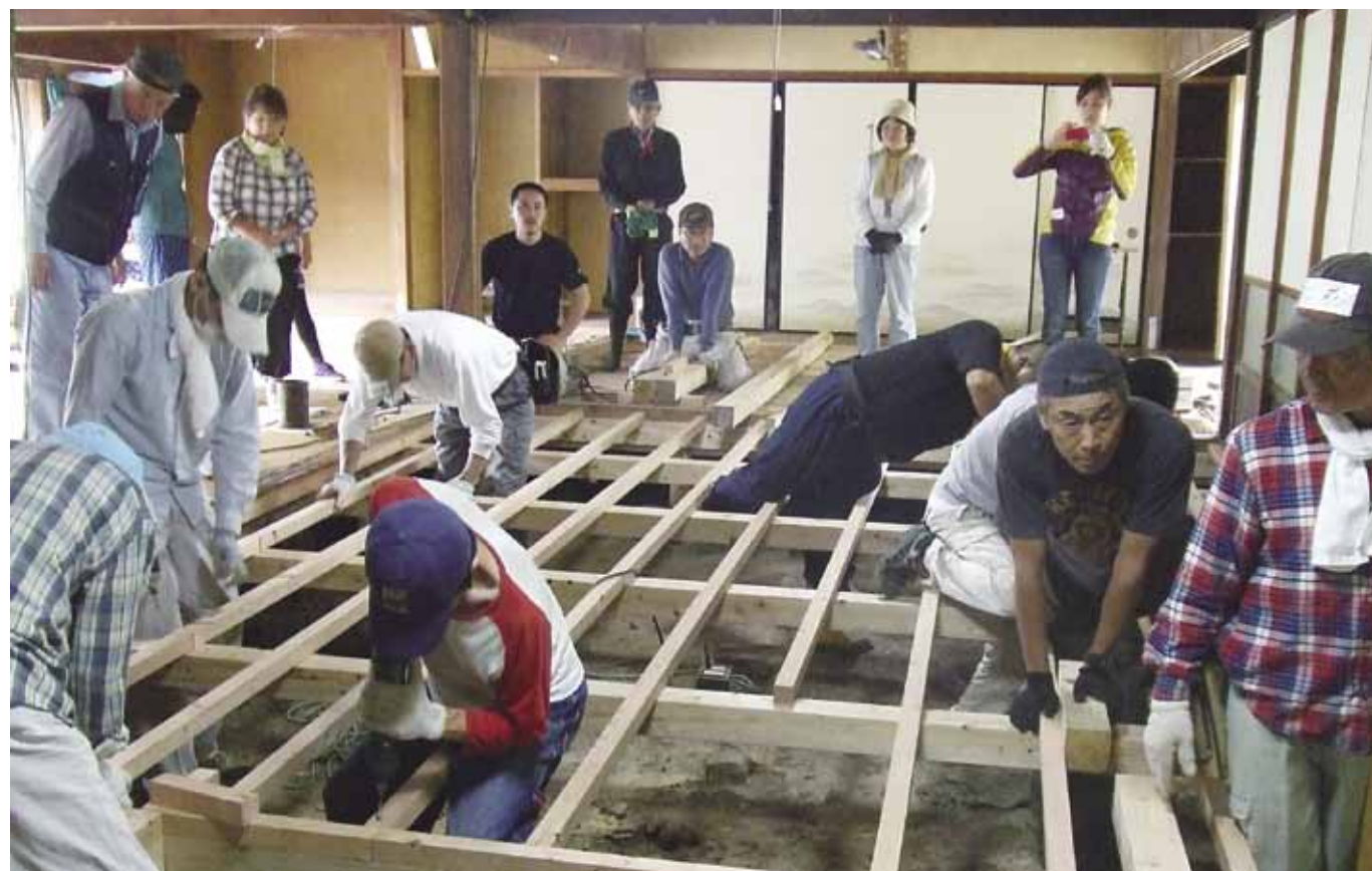
棟梁の指示を受け、床下部分のはめ込み作業を参加者が行う。
