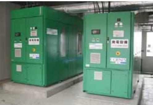
家畜ふん尿の処理過程で発生するバイオガスを燃焼し発電する。2台で300kwの能力で発電したエネルギーは施設内で利用し、余剰分は売電している。
