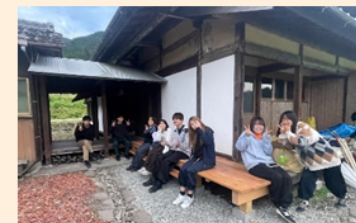
空き家の改修
