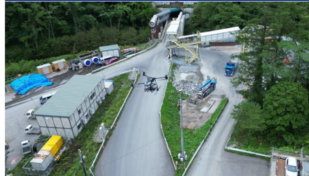
ドローンによる トンネル坑外の3Dスキャン
