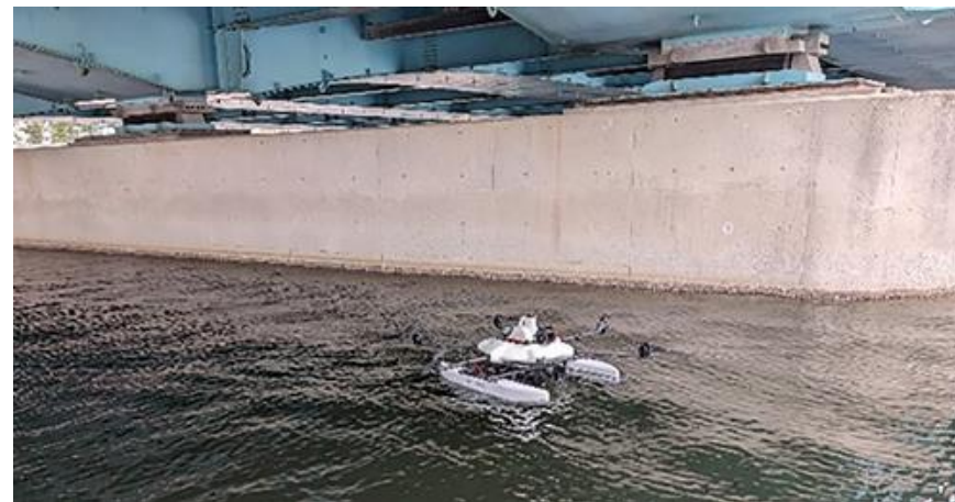
橋脚水中点検実証の様子
