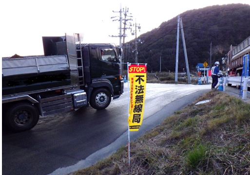
工事現場に設置したのぼり旗
