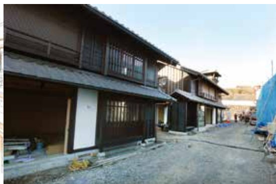
建設中の小江戸甲府花小路。9棟18テナント。完成後は飲食店や土産物店などが入る予定。
