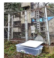
可搬型衛星アンテナ
