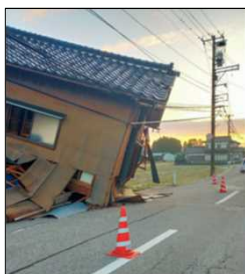
ケーブルの断線
