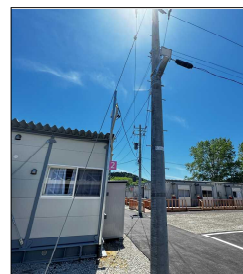
仮設住宅への整備
