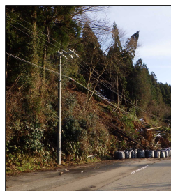
ケーブルの復旧
