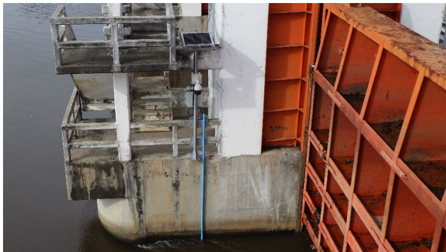
機器取付状況
