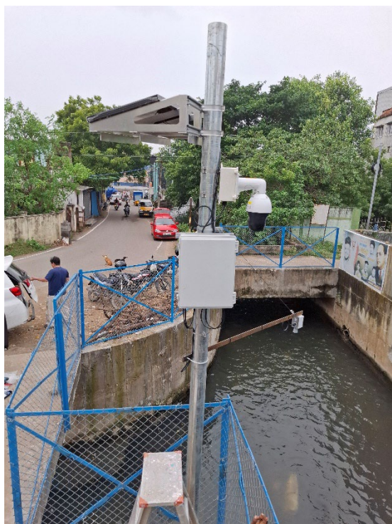
機器取付状況
