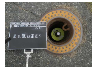
ボールポイントロッドの設置状況
