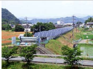
用水路上部を利用した太陽光発電所
