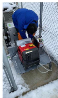
ポータブル発電機の給油作業の様子
