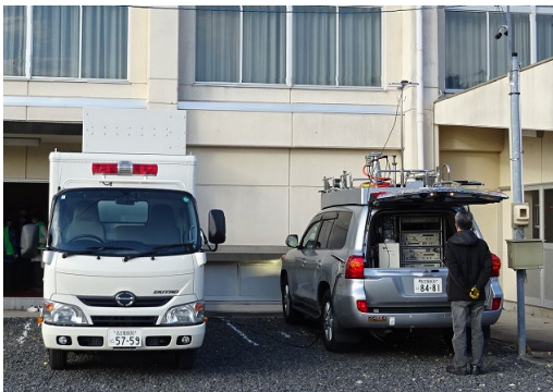
当局の移動電源車からNHKの非常用通信車両に電源を供給
