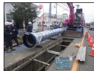
（耐震管の敷設工事）
