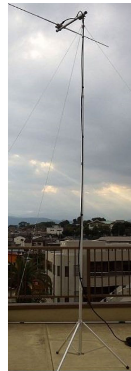
アンテナ(組立後)
