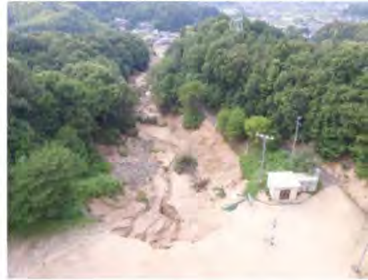
【豪雨により農業用ため池が決壊した事例】
