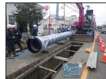
(耐震管の敷設工事)
