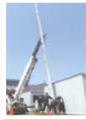
電柱の建て替え
