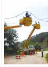
通信ケーブルの 張り替え
