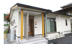
空き家の改修（お試し居住施設）
