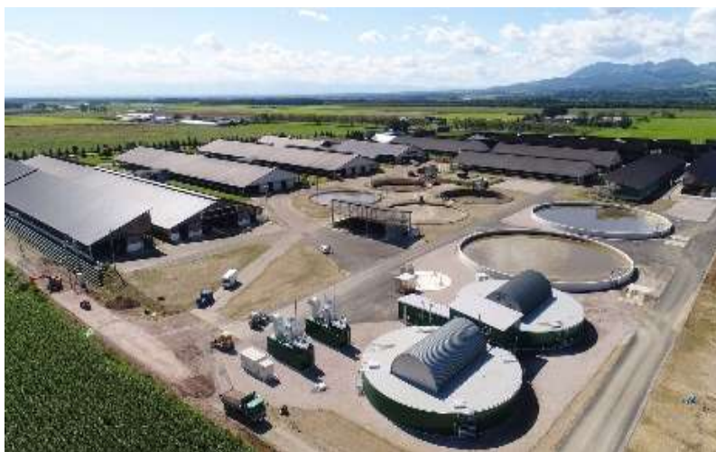
バイオガスプラント
