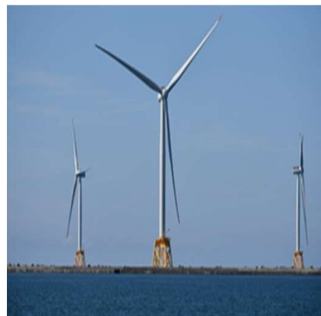
石狩湾新港洋上風力発電所
