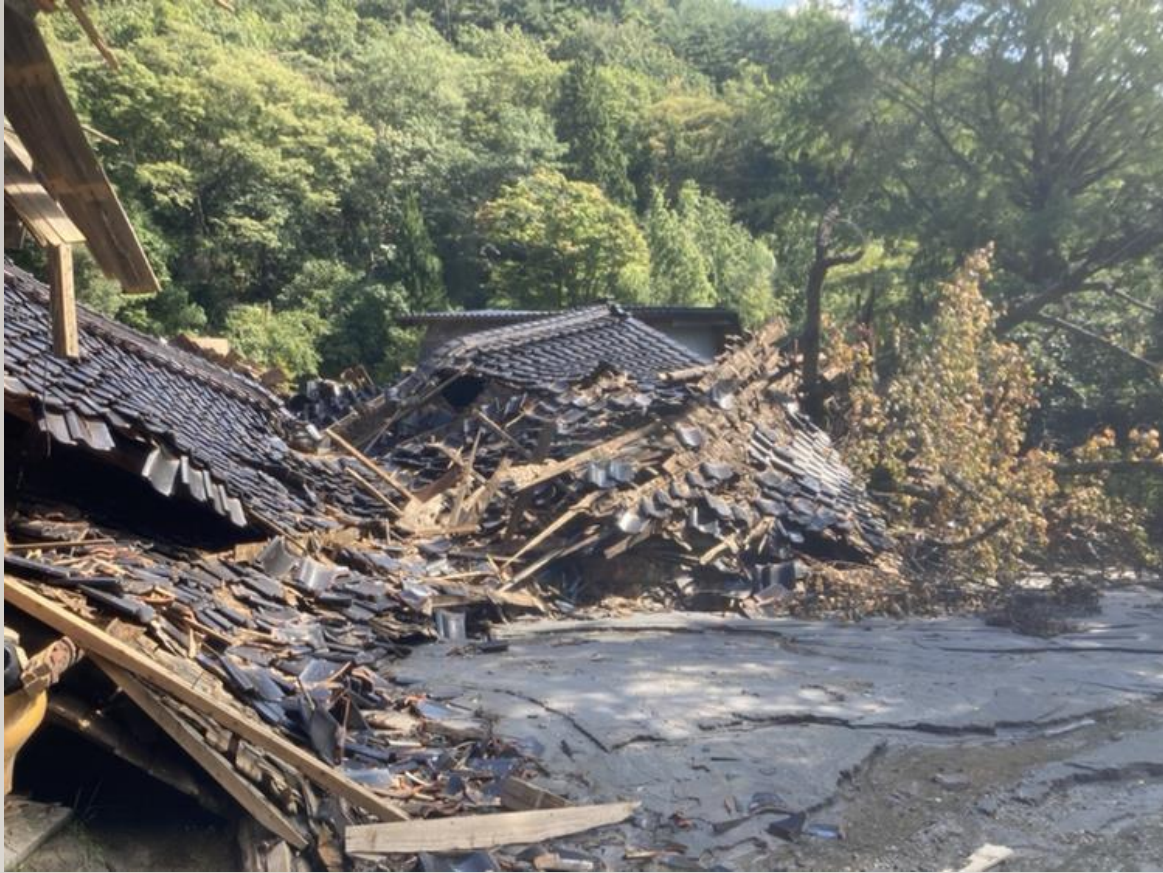
岩倉寺 住居崩壊 (地震では本堂のみ崩壊)
