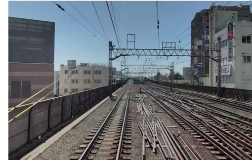
誤検知の結果（遮断桿のない区間を検出した例）
