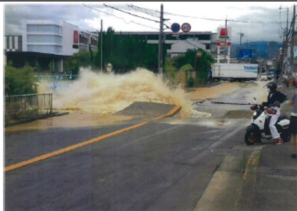
大阪府北部を震源とする地震による水道管の破損現場(2018年)
