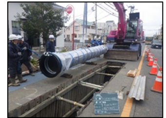
（耐震管の敷設工事）
