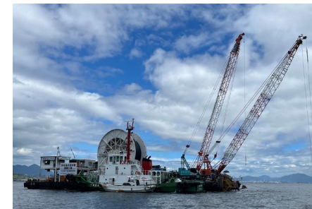
宮島海底送水管の管路布設工事
