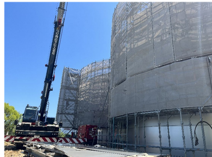
江田島市水道事業第 2 配水池築造工事
