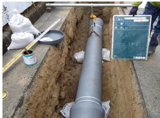
管路更新（耐震化）工事
