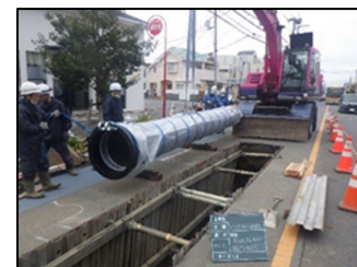
(耐震管の敷設工事)
