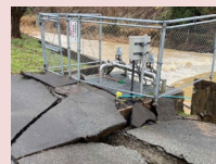
水道の復旧 (被災した浄水場)
