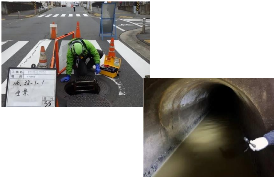
下水道管路の緊急点検の様子 (目視点検)
