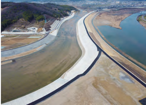
小田川合流点付け替え事業。高梁川と小田川の合流点を付け替えたほか、河道掘削などを行った。
