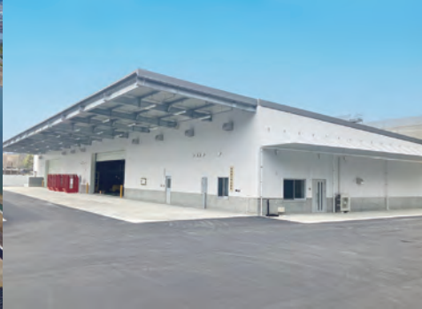
昨年3月に整備した有城 あるき 防災備蓄倉庫。10tトラック32台分の食糧や飲料水などを備蓄できる。
