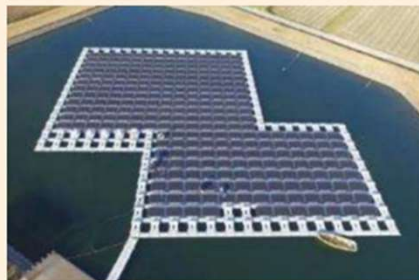
ため池フロートソーラー発電所
