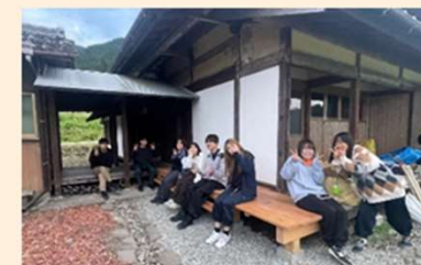
空き家の改修
