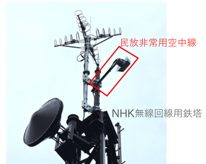
輪島R 鉄塔への空中線取付状況
