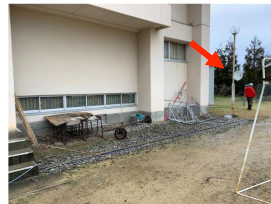
仮設のBSアンテナの設置
