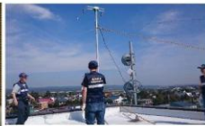
役場屋上に設置された臨時災害放送局のアンテナ
