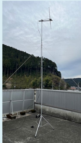
消防署へのアンテナ仮設
