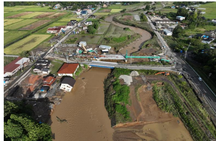
【家屋の流出（珠洲市若山町）】
