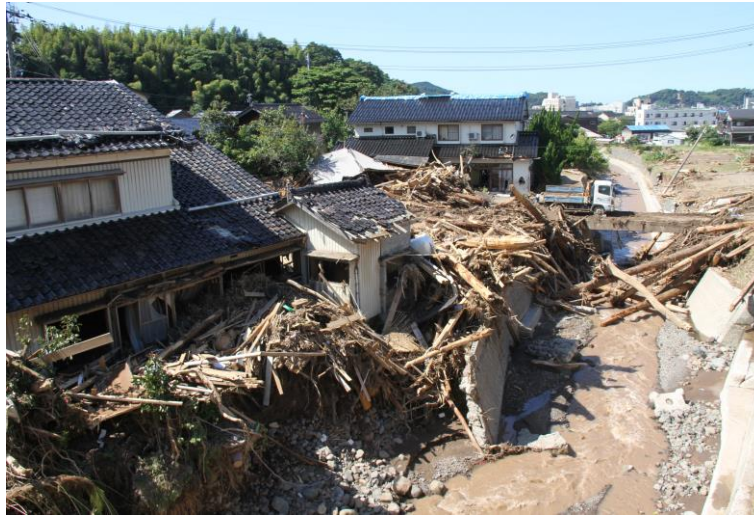
【家屋の流出（輪島市久手川町）】
