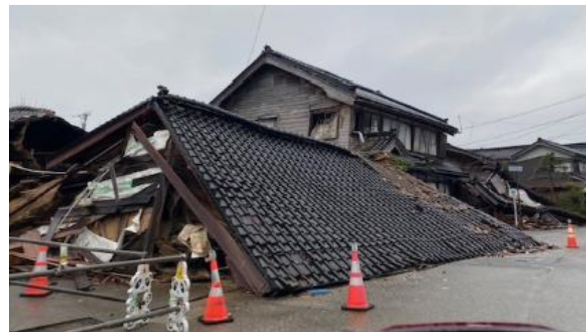
建物倒壊（珠洲市三崎町地内）
