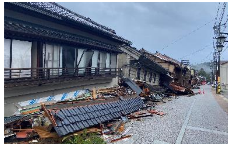
建物倒壊（輪島市門前町地内）
