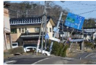
内灘町西荒屋地内 (液状化)
