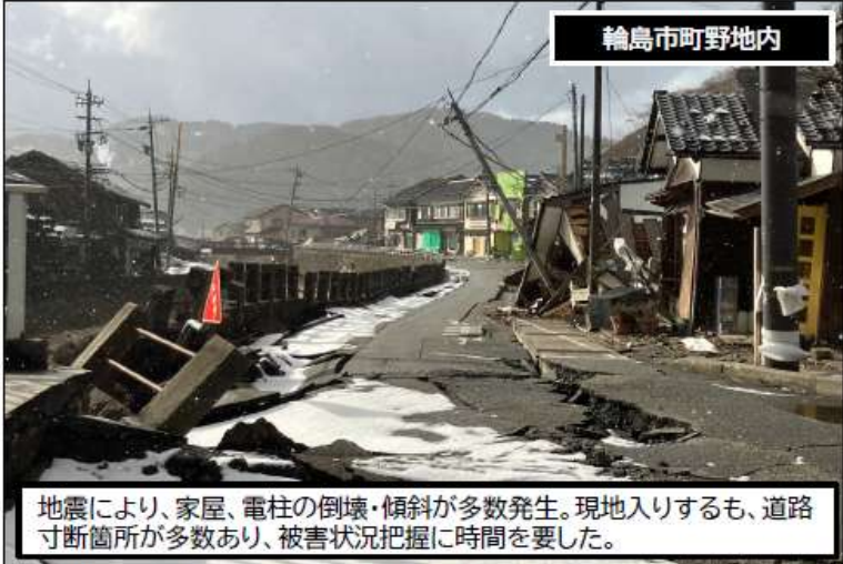
輪島市内では火災により、幹線ケーブルも被災。市内は、家屋倒壊によりPS柱も損壊。各所で電柱の倒壊・傾斜が確認される。
