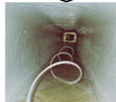
特殊な部材により既設管渠の内面を被覆
