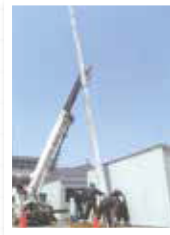
電柱の建て替え
