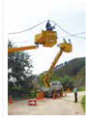
通信ケーブルの 張り替え
