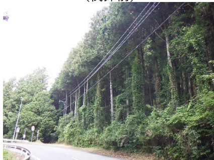
図3 停電予防を目的とした事前伐採の例（三重県大台町提供） （伐採前） （伐採後）
