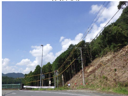
図3 停電予防を目的とした事前伐採の例（三重県大台町提供） （伐採前） （伐採後）
