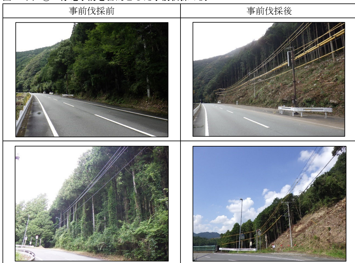
図 1-(1)-② 停電予防を目的とした事前伐採の例
