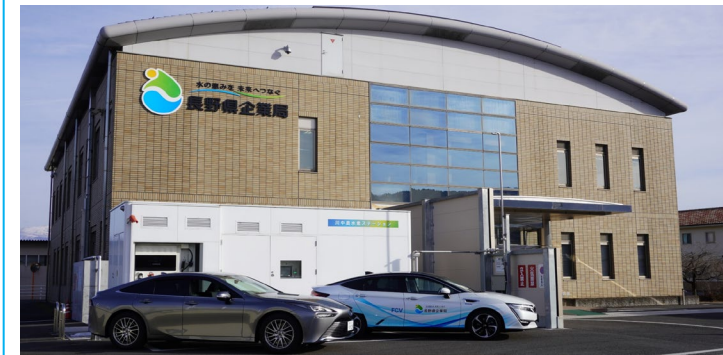
川中島水素ステーション
