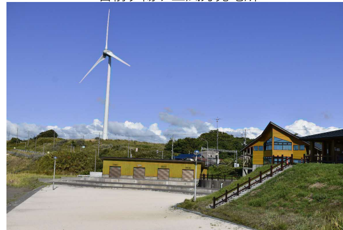
苫前夕陽ヶ丘風力発電所
