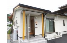
空き家の改修(お試し居住施設)
