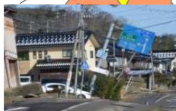
内灘町西荒屋地内（液状化）
