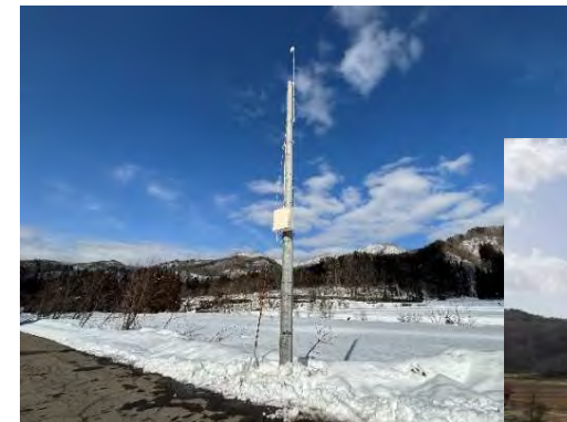
▲ 屋外アクセスポイント設備 (UPSを搭載しており、停電時も稼働可能)
