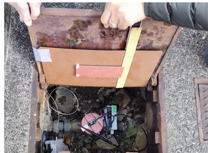
写真下：量水器の鋳鉄蓋内側への試作アンテナの取り付け確認の様子
