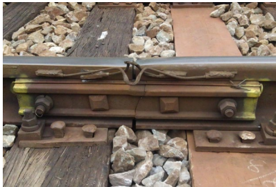
継ぎ目板（折損イメージ）
