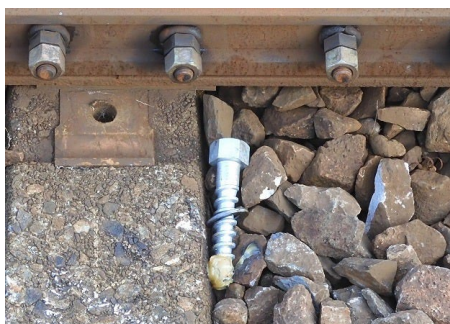
レール締結装置（ボルト脱落イメージ）
