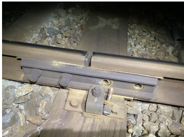
継ぎ目板（ボルト脱落イメージ）
