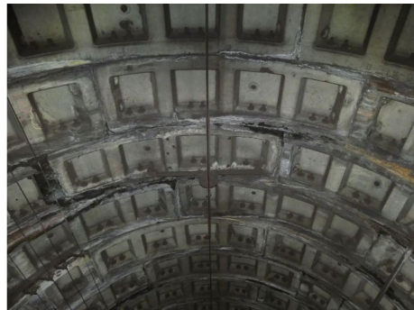
トンネル上部の水濡れ
