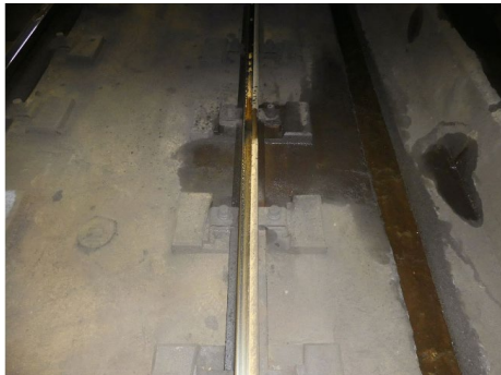
コンクリート道床のレール付近水濡れ
