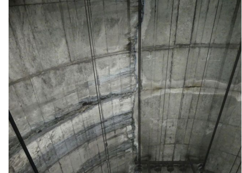
トンネル上部の水濡れ
