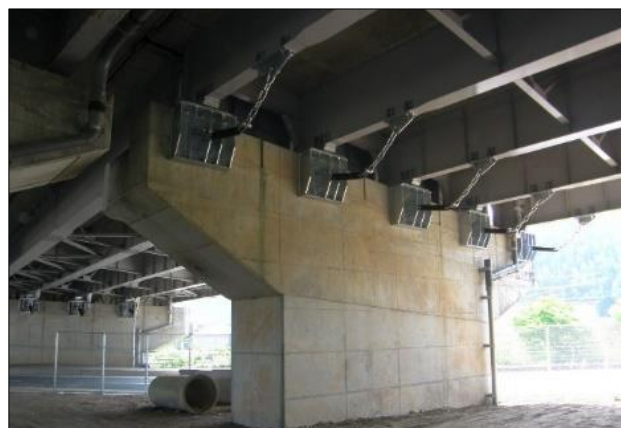
○ 橋梁の耐震補強
