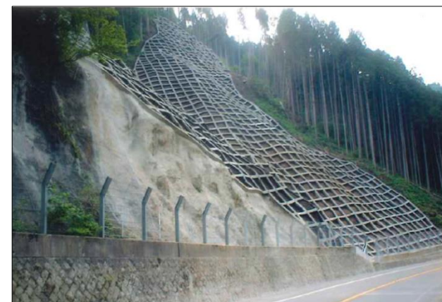
○ 落石防止対策(法面工)
