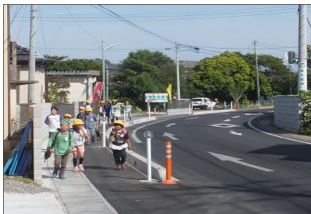
○ 安全な通学路空間に向けた整備
