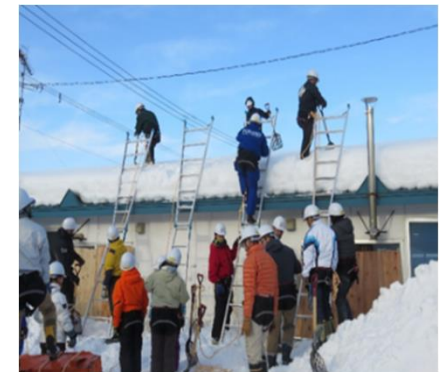
雪下ろし実技講習
