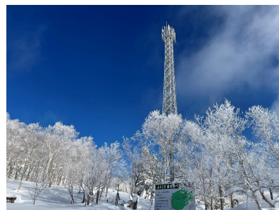
<完成した基地局>
