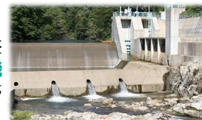
町営小水力発電所
