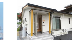
空き家の改修（お試し居住施設）
