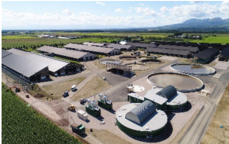
バイオガスプラント
