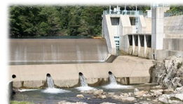
町営小水力発電所
