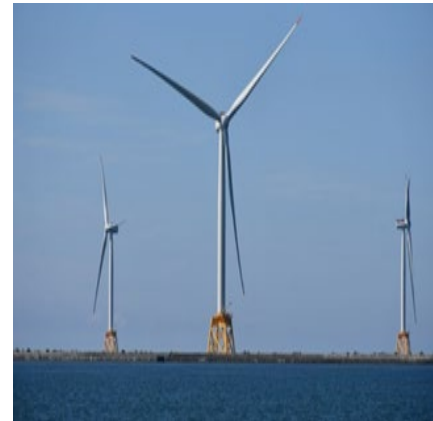
石狩湾新港洋上風力発電所
